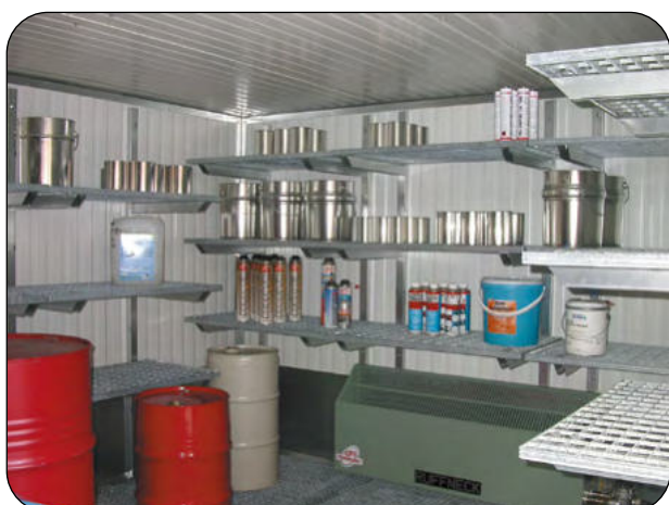
Ausrüstung mit Regalteilen zur Nutzung als Kleingebindelager
