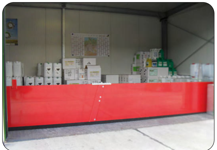
Löschwasserrückhaltung mit dreh-klappbarer Barriere
