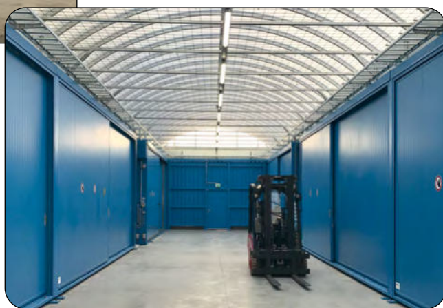
◆ Gangüberdachung mit Dachlichtband ◆ Gangbeleuchtung
