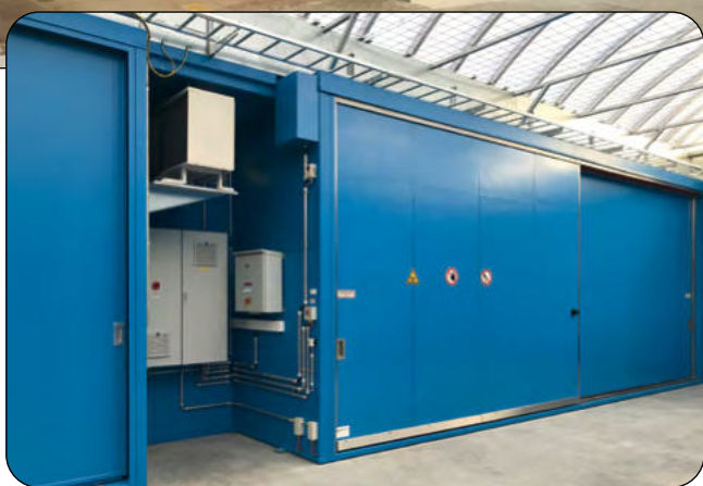
◆ Separater Brandabschnitt mit integriertem Brandschutzcontainer
